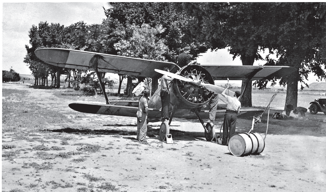
Заправка горючим истребителя И-15 из бочки вручную на полевом аэродроме Abastecimiento manual de un I-15 desde un barril en un aeródromo de campo
